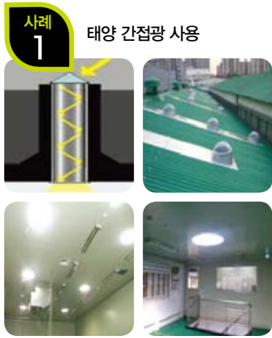
태양 간접광시스템 설치
